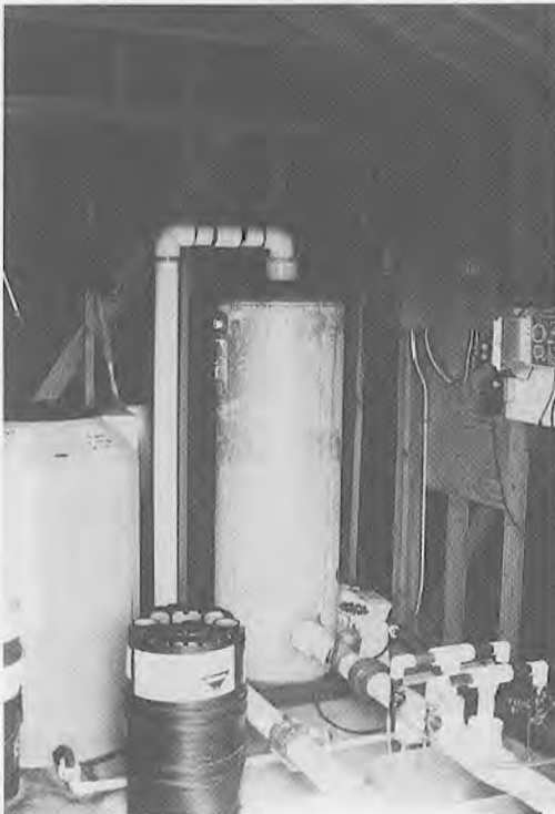
Fig. 6.73. Sistema de inyección con depósito para ácidos a la izquierda, depósito mezclador en el centro y parte del sistema inyector abajo a la derecha, con controlador de riego arriba. (Cortesía de California Watercres, Inc, Fillmore, CA).
