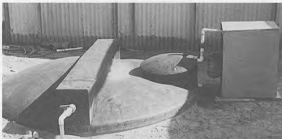
Fig. 11.17. Cisterna de 2.500 galones con bomba a la derecha. (Cortesía de California Watercress, Inc., Fillmore, CA).
