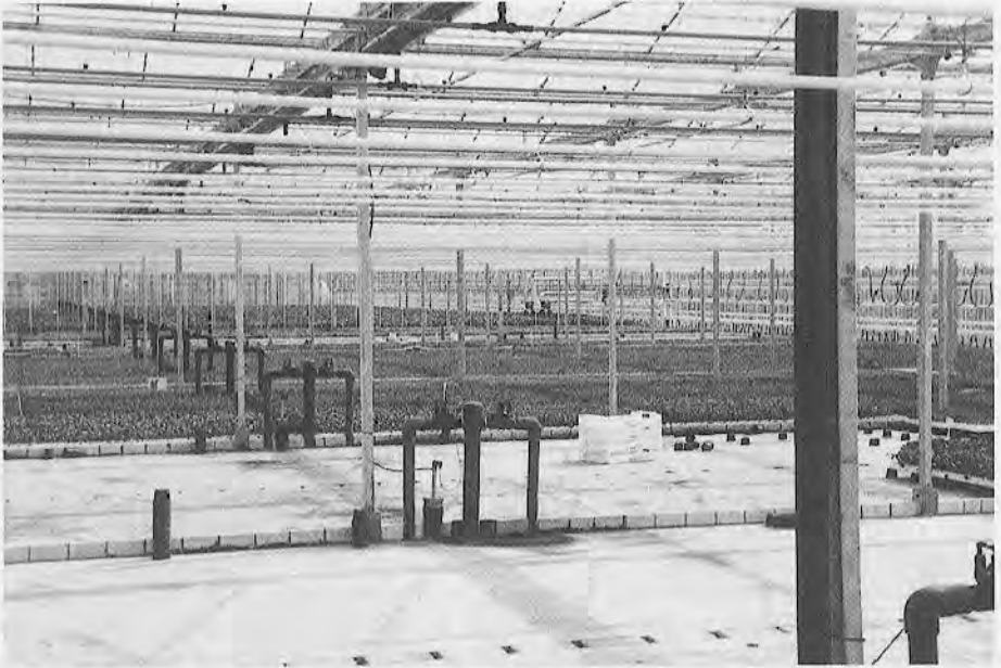
Fig. 6.62. Sistema de flujo y reflujo con suelo de hormigón para el cultivo de trasplantes. Obsérvense los lados de ladrillo de las bancadas y la ligera pendiente hasta el canal central de llenado y drenaje. (Cortesía de Bevo Farms Ltd., Langley, B. C, Canadá).
