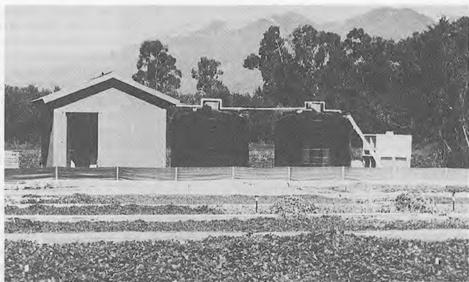
Fig. 6.74. Dos tanques de solución stock de 2,300 galones con cobertizo para el inyector a la izquierda. (Cortesía de California Watercress, Inc., Fillmore, CA).
