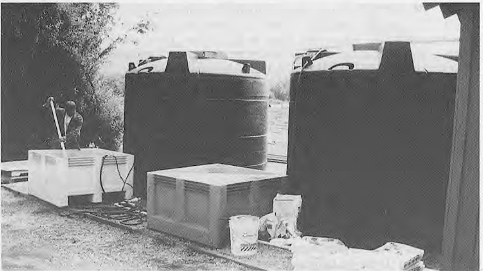
Figura 3.9. Depósito mezclador con bombas para tanques de stock. (Cortesía de California Watercress, Inc., Fillmore, CA).
