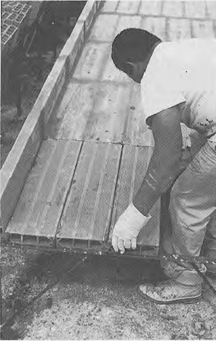
Fig. 12.6. Fondo de ladrillo de arcilla de las bancadas hidropónicas. (Cortesía de Hidroponías Venezolanas, S.A., Caracas, Venezuela).
