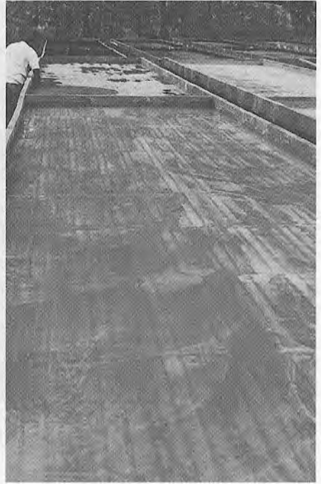
Fig. 12.7. Bancadas niveladas con una capa de hormigón. (Cortesía de Hidroponías Venezolanas, S.A., Caracas, Venezuela).
