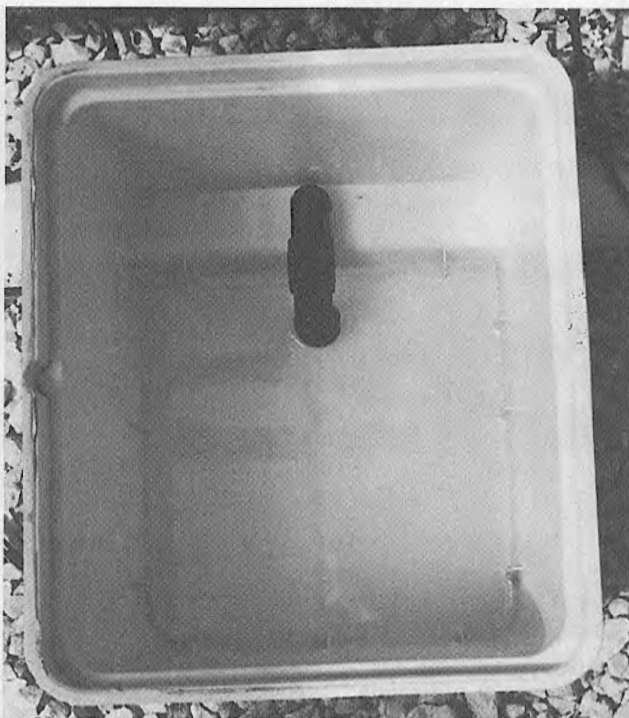
Fig. 11.42. Sifón en la base de un cubo bato.
