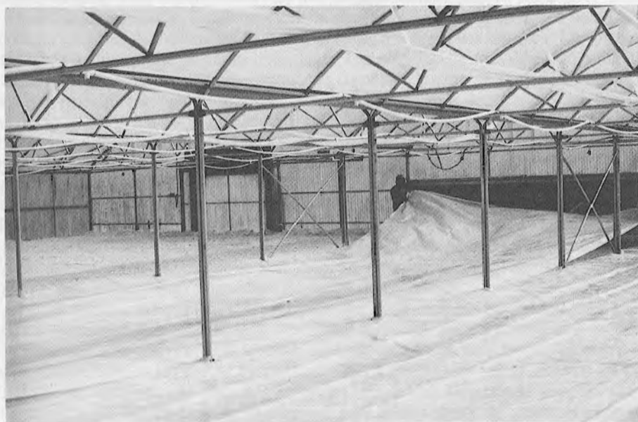
Fig. 10.12. Colocación de la lámina de cobertura de polietileno blanco.
