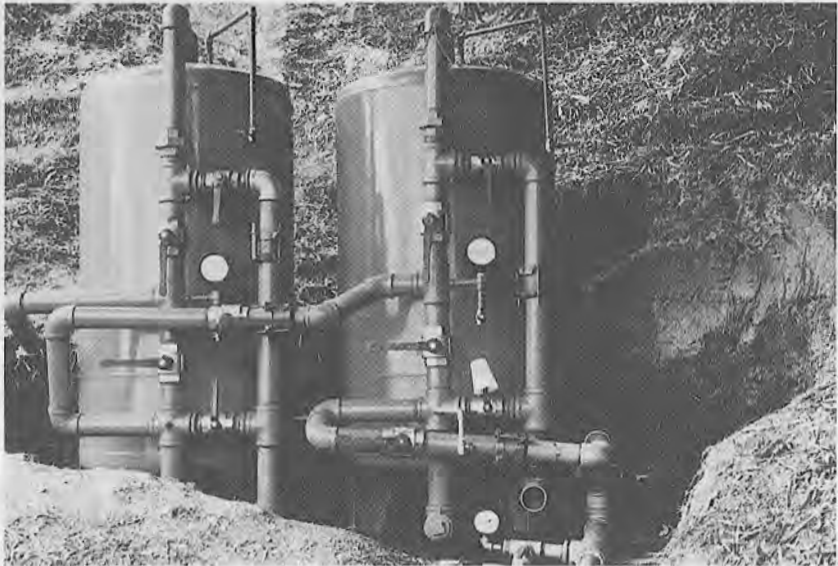
Fig. 12.2. Sistema de filtración del agua de una fuente de montaña. (Cortesía de Hidroponías Venezolanas, S.A., Caracas, Venezuela).
