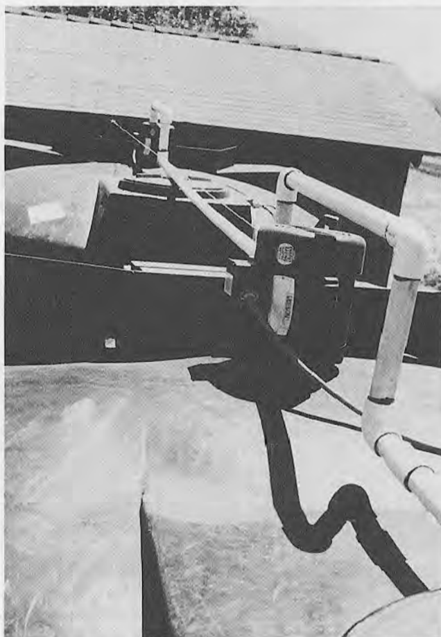
Figura 3.5. Tanques de stock (2,300 galones) A y B con bombas de circulación. (Cortesía de California Watercress, Inc., Fillmore, CA).
