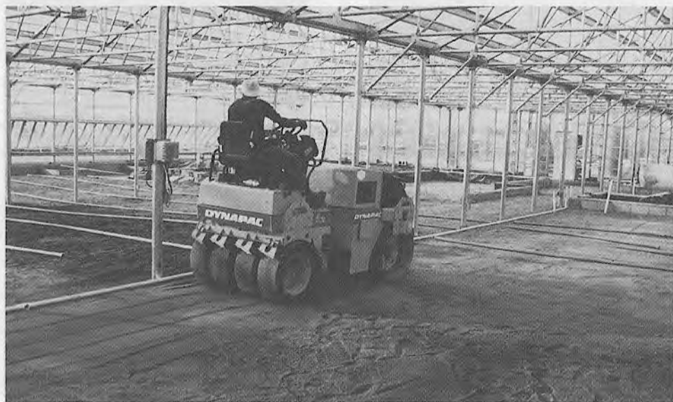
Fig. 11.39. Tuberías de drenaje cubiertas con relleno de arena apisonada. (Cortesía de CuisinArt Resort & Spa, Anguilla).
