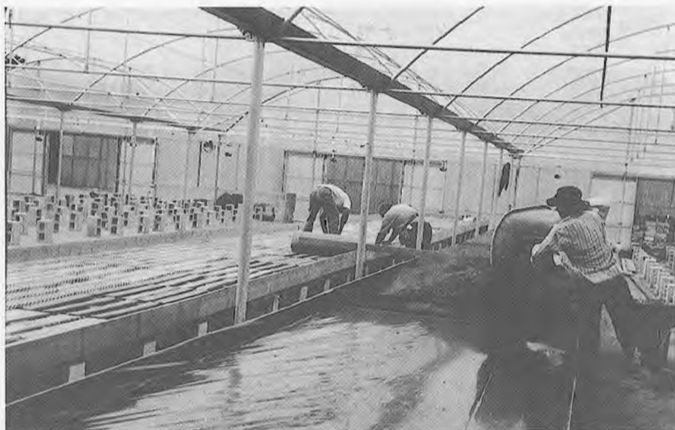
Fig. 11.4. Colocación de un medio de cultivo «Peat-Lite» en la bancada finalizada. Obsérvense las bancadas en construcción a la izquierda. (Cortesía de California Watercress Inc., Fillmore, California).
