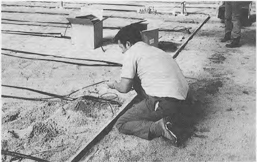
Fig. 8.9. Instalación de las tuberías de rezume en un sistema automático de riego. (Cortesía de Superior Farming Company and the Environmental Research Laboratory, Tucson, Arizona).
