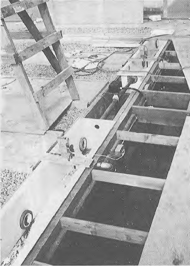
Fig. 7.9. Válvula automática de tres vías utilizada en el diseño de un pleno dividido.
