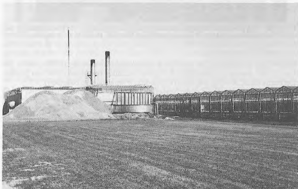
Fig. 10.42. Houweling Nurseries Ltd., un invernadero de 30 acres, utiliza serrín como combustible para sus calderas de agua caliente para calefacción. (Cortesía de Houweling Nurseries Ltd., Delta, B. C., Canadá).
